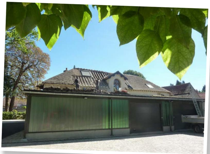
Pour clore cette année 2018 en travaux, c'est la toiture des ateliers municipaux qui vient d'être refaite, la charpente remaniée, l'isolation thermique réalisée et les écoulements des eaux de pluies remis en état. Cette dernière étape signe la fin du contrat rural subventionné qui aura vu la restauration de la serre et des ateliers municipaux et un volet paysager important des abords et des accès de ces ateliers.
