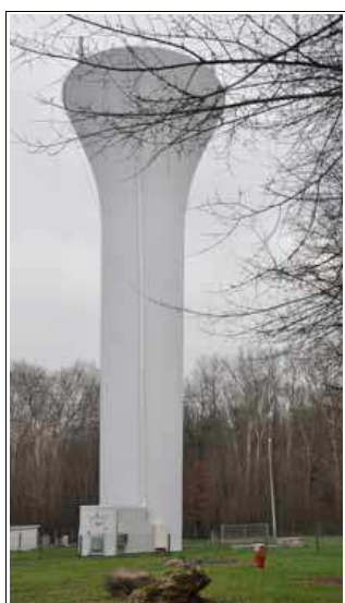
Château d'eau communal
